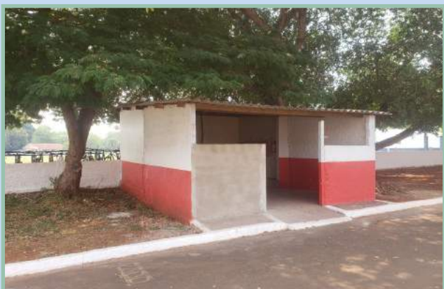
Adequação da antiga lixeira em Posto Combate à Incêndio
